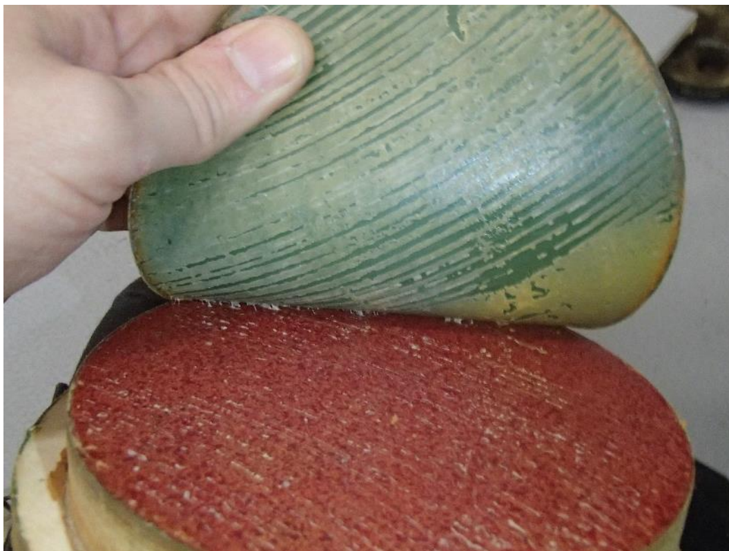
Kuva 11. Vanhan vinyylimaton liima oli tahmeaa ja tuoksui voimakkaasti.
