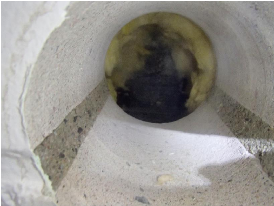
Kuva 2. Rakenneavaus RAKS1 liikuntasalin ulkoseinärakenteeseen.
