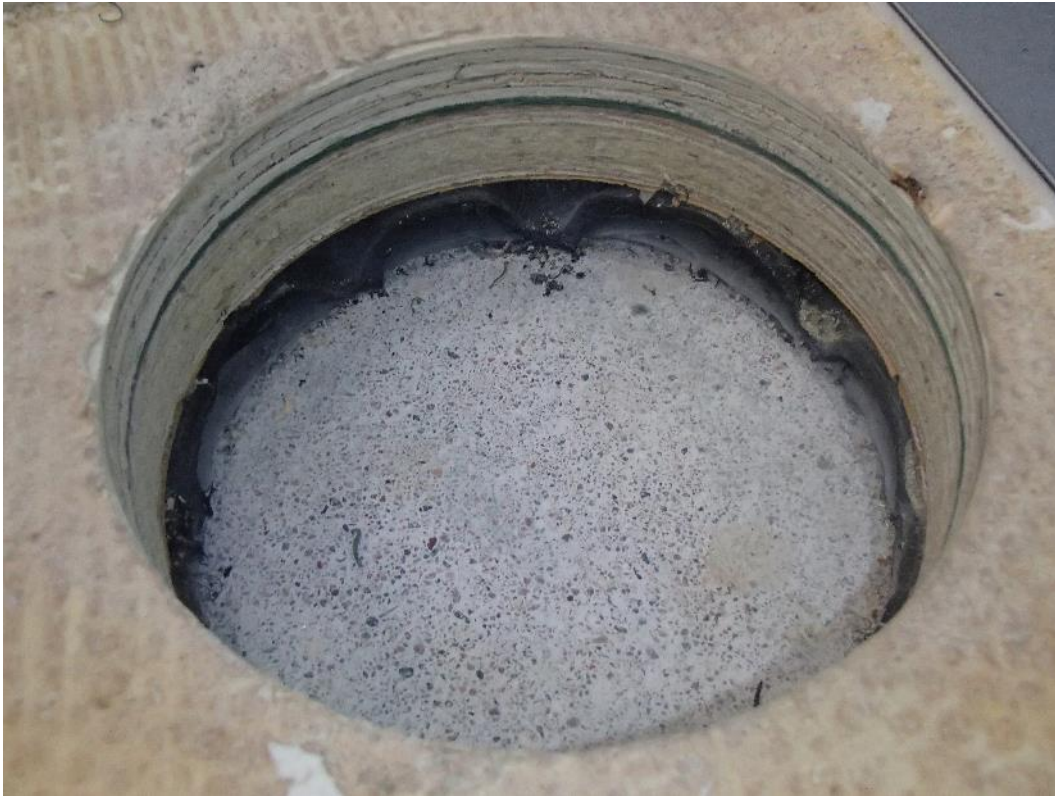
Kuva 7. Rakenneavauksen RAKL1 rakenteet.
